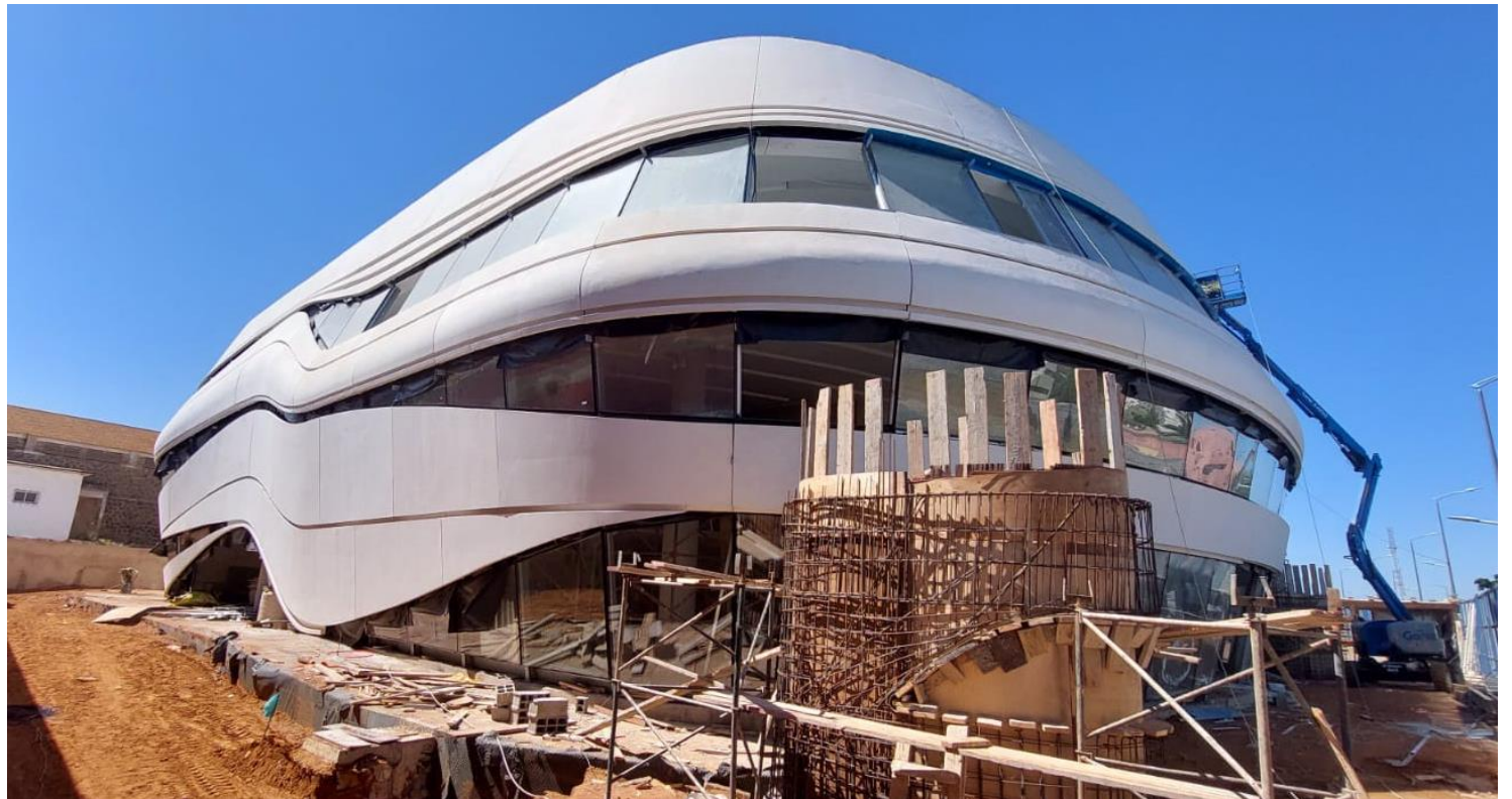
Nouvelle succursale de Kénitra en cours de construction : architecture moderne et respect des principes du développement durable
